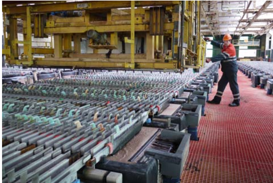
In het zogenoemde celhuis wordt zinkmetaal onder invloed van elektrische stroom neergeslagen op negatieve elektrodes (kathodes). De zinklaag die zich op de kathodeplaten vormt, wordt automatisch gestript en afgevoerd naar de smelterij. In de smelterij wordt het zink via geïsoleerde gietgoten gesmolten en gegoten tot blokken.
